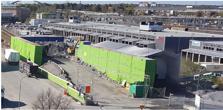
Figur 15 Begränsning av damning från krossverksamhet med hjälp av barriärer.
